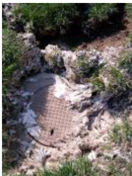
9. A nagy esőzések miatt kiöntött a szennyvízcsatorna a Mogyoródi úti híd lábánál...
